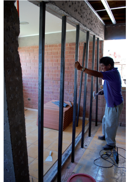
Instalación de las reglas metálicas
