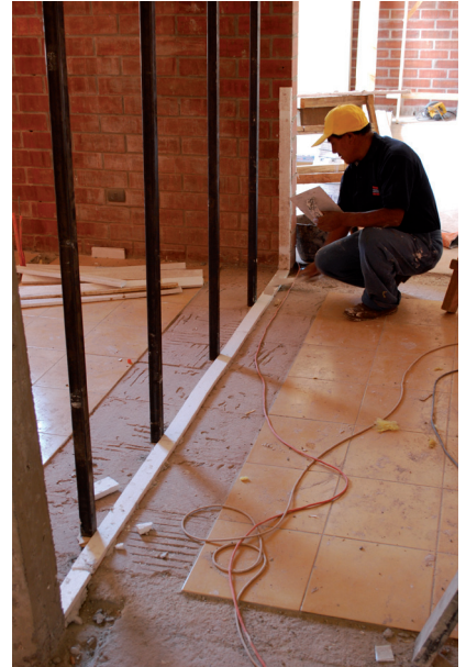
Instalación de las dilataciones
